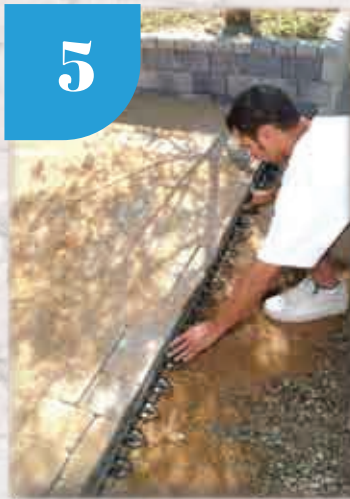
5 Install Edge Strip
