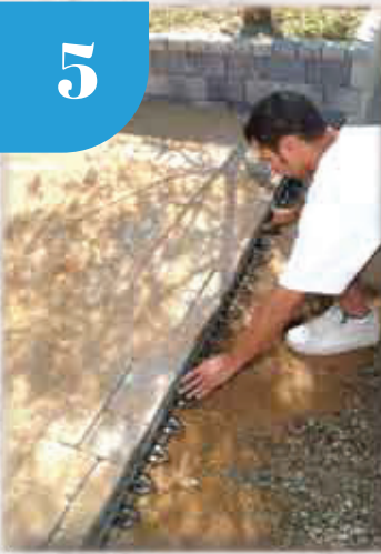
Install Edge Strip
